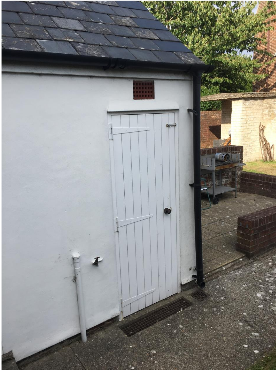
Existing WC Door
