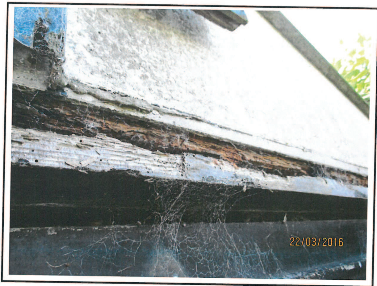
Garage door frame
